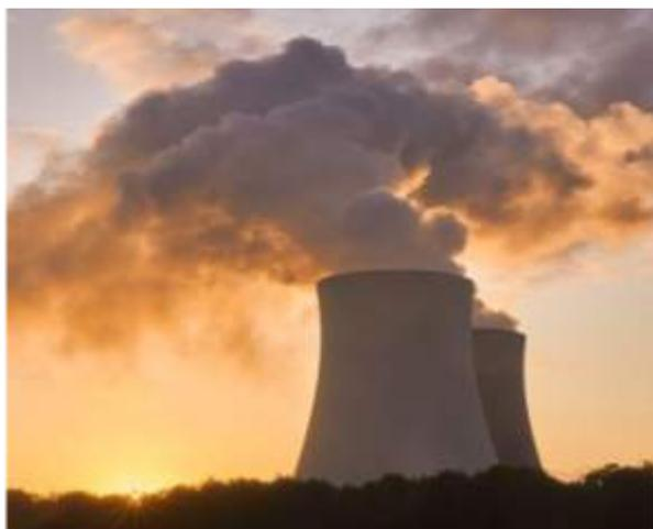
**A USINA NUCLEAR.** A geração de energia nas usinas nucleares é obtida por meio do calor emitido durante a fissão nuclear controlada. A fissão nuclear ocorre quando um núcleo instável de um átomo se desintegra em núcleos menores, produzindo uma reação em cadeia que libera muita energia. Essas usinas são responsáveis por 10% da eletricidade gerada no mundo. Imagem: pixabay.com
